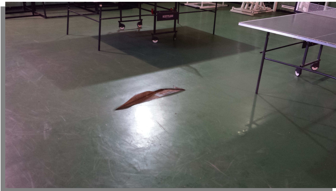
Foto n° 5 – Palestra – Particolare pavimentazione
